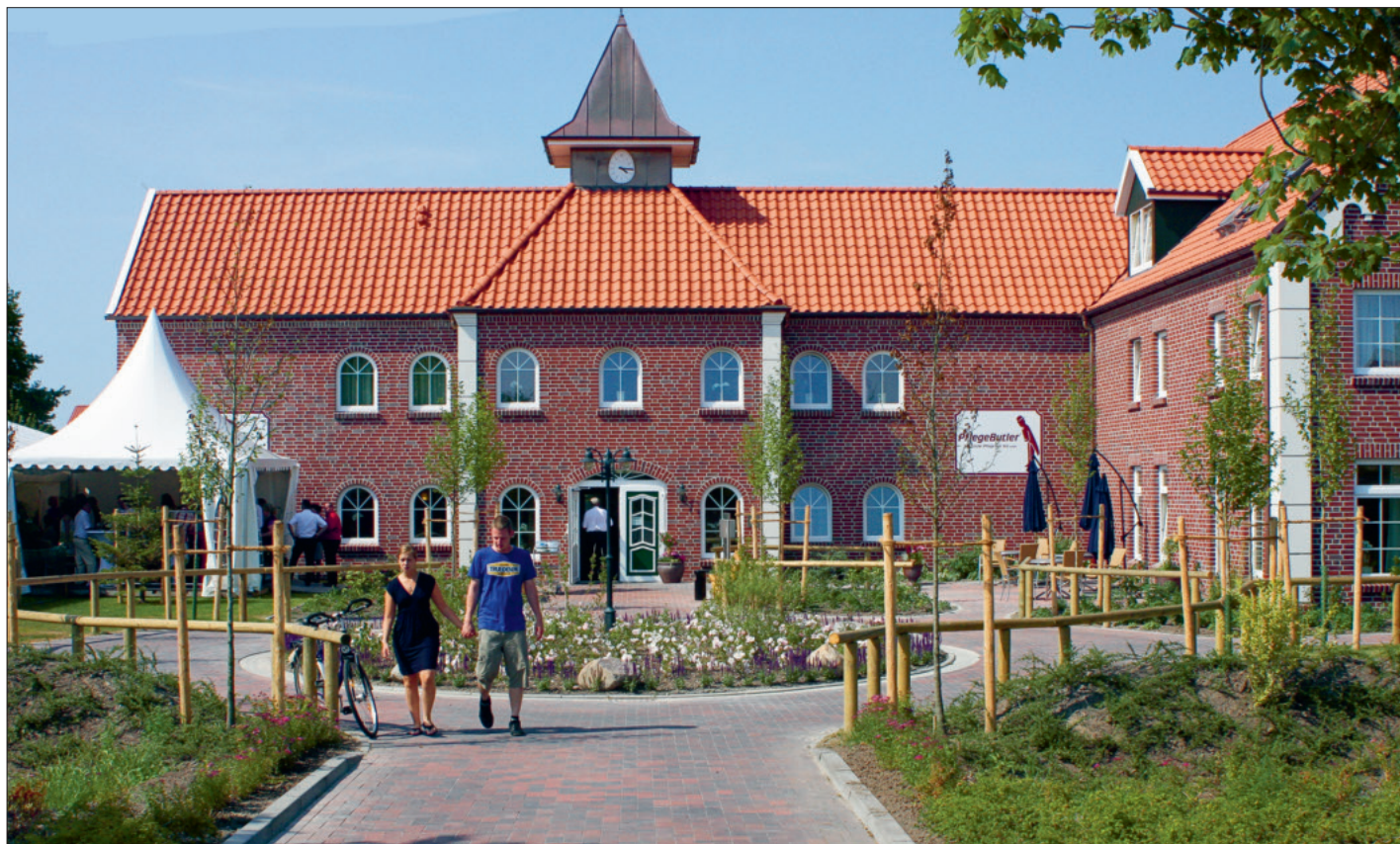
Im Stil eines Gulfhofs ist der Pflegestützpunkt „Peter Ei“ an der Schlossstraße gebaut worden, ein optischer Leckerbissen.
