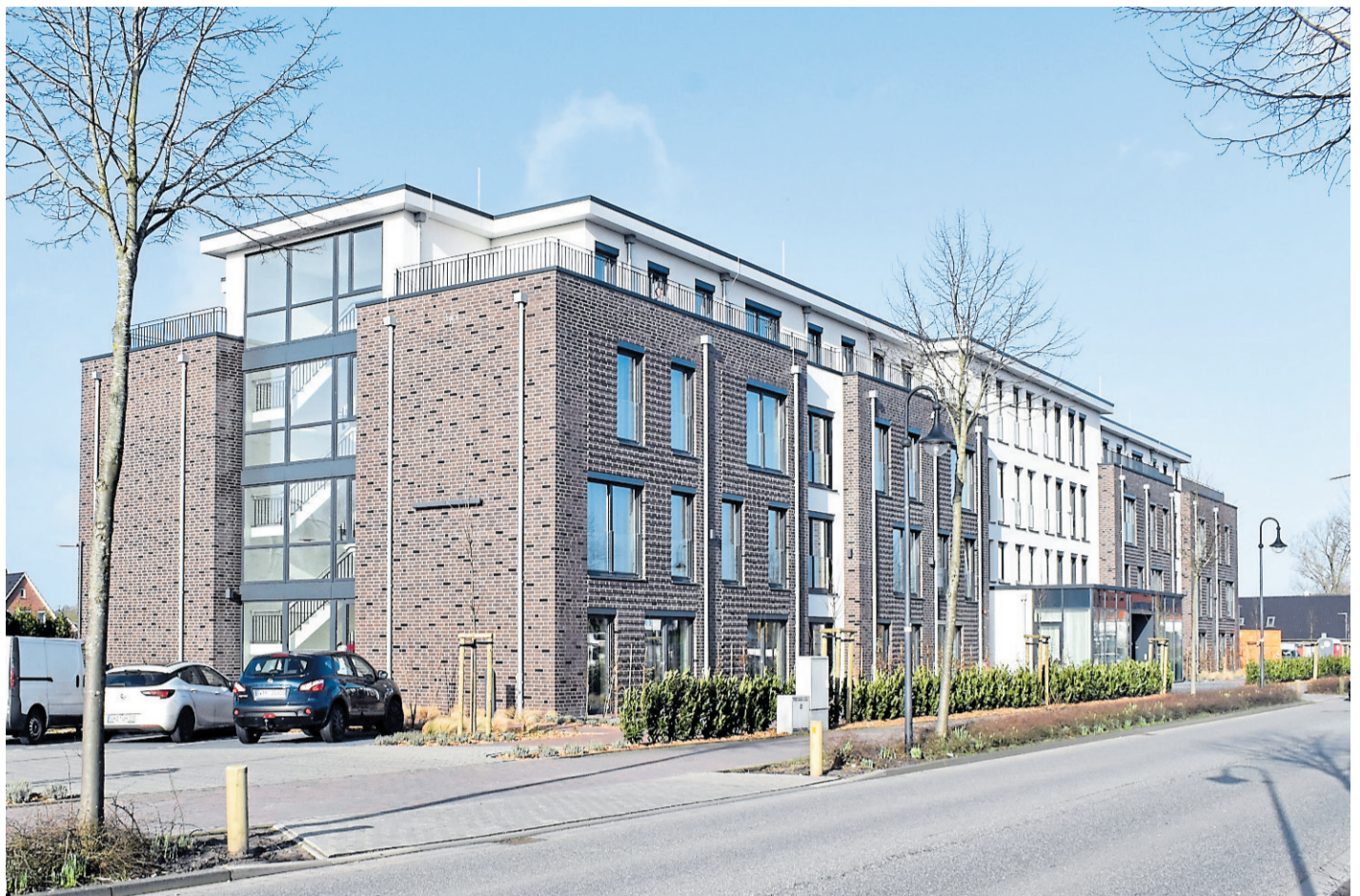
Rund zwei Jahre hat es gedauert, bis der Wohnpark Jever fertiggestellt wurde – morgen wird er eröffnet. BILDER: ANTJE BRÜGGERHOFF
