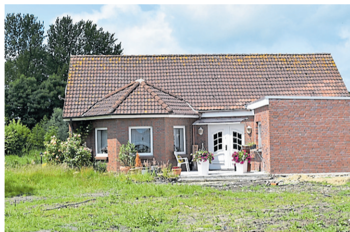
Nur noch das private Wohnhaus der Familie Freese ist auf dem Areal der „Alten Schmiede“ stehen geblieben.
