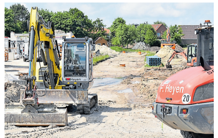
Für die Straße Nordorfer Burg laufen derzeit die Erschließungsarbeiten.
