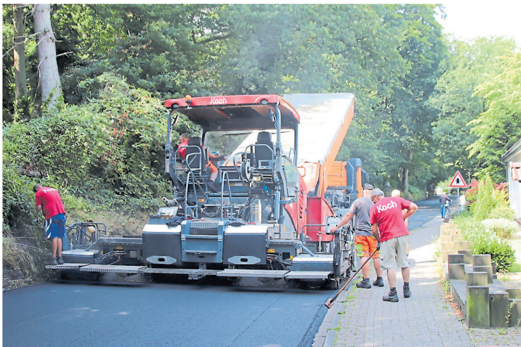
Mit dem Auftragen der neuen Asphalt-Deckschicht wird die dringend notwendige Instandsetzung des Strooter Wegs in Friedeburg abgeschlossen.
