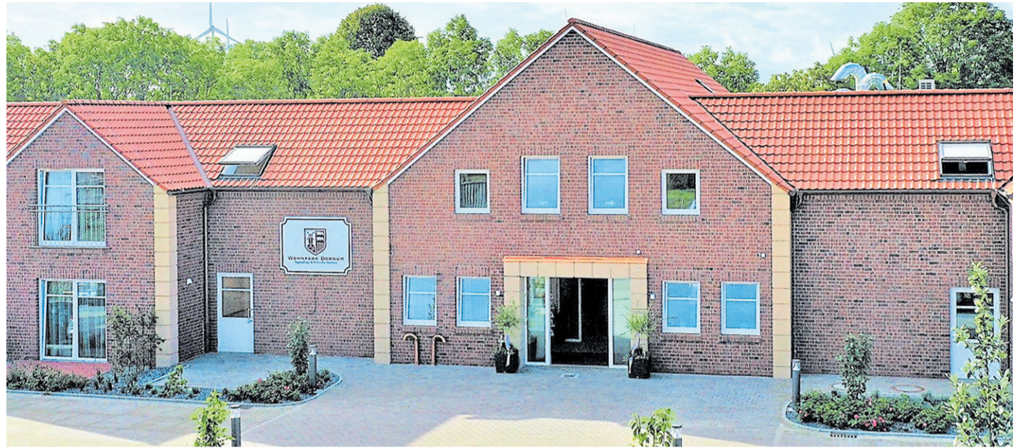
Der Pflegebutler-Neubau des Wohnparks an der Hartwarde Straße in Esens soll der im September eingeweihten Einrichtung in Dornum architektonisch gleichen.
