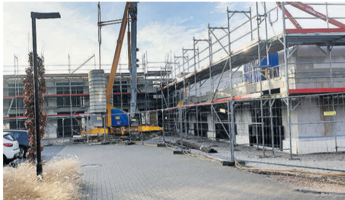
Der Rohbau des zweiten Apartmenthauses ist schon weit fortgeschritten: Bald beginnt der Innenausbau, am 1. Oktober soll das neue Haus eingeweiht werden. BILD: DORIS GROVE-MITTWEDE
