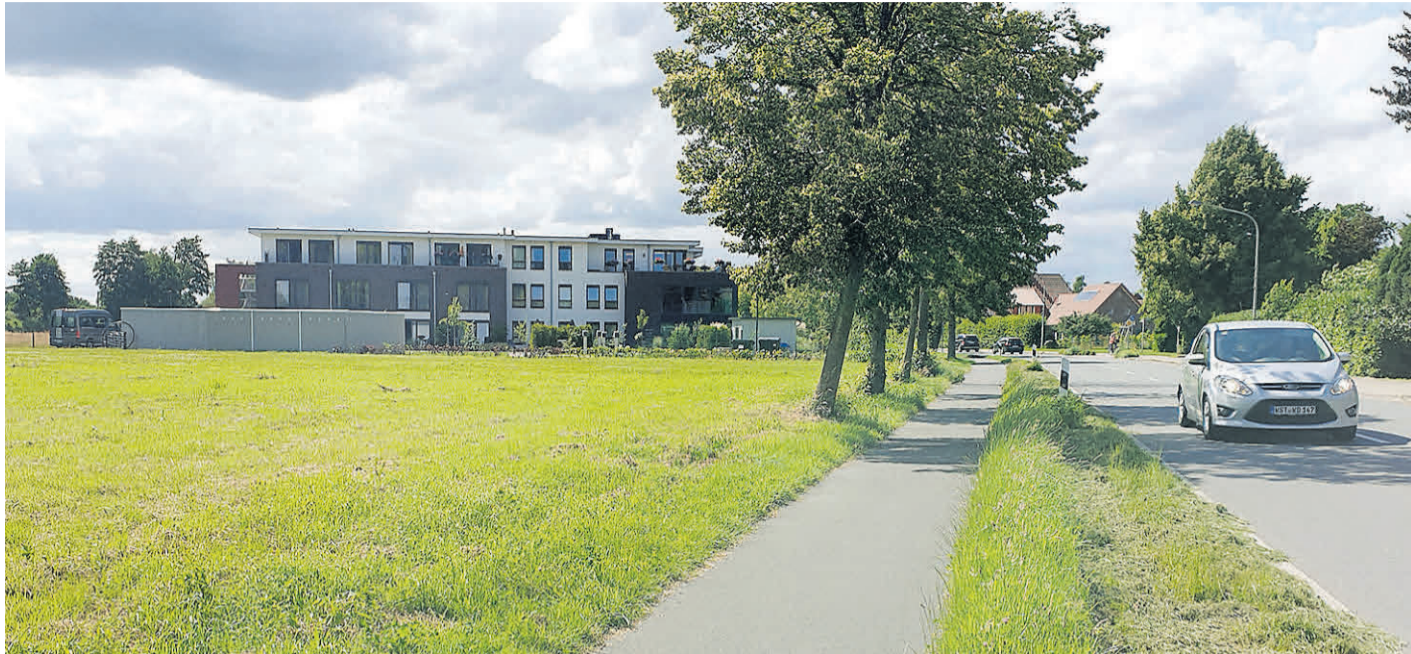
Noch Grünfläche, doch bald soll auch hier gebaut werden: In unmittelbarer Nähe zum Pflegebutler plant ein Oldenburger Investor Betreutes Wohnen.
