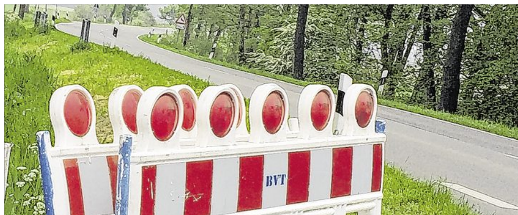
Die Landesstraße 21 zwischen Potshausen und Stickhausen ist repariert worden. Die Absperrbaken stehen aber noch bereit, weil die Seitenstreifen jetzt noch angepasst werden.
