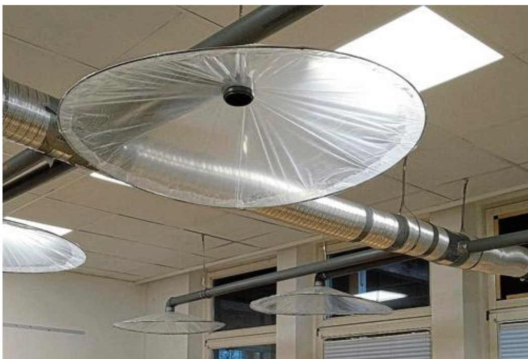
Pilotprojekt an der Grundschule Roffhausen: Wie Regenschirme hängen die selbstgebaute Abzugshauben über den Tischen der Schüler
