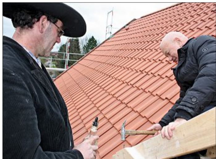
Den letzten Nagel musste Bauherr Peter Janssen (r.) einschlagen. Zimmermeister Lars Deutschkämmer sorgte mit „flüssiger Nahrung“ für Stärkung.
