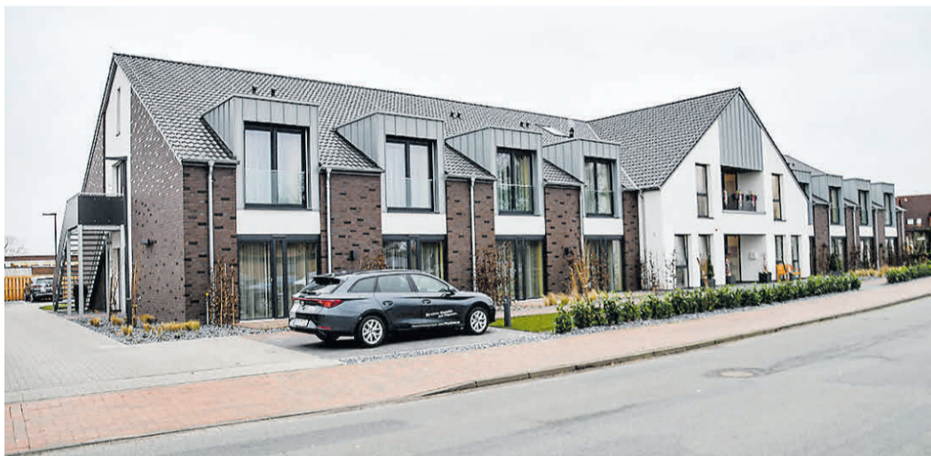
Der Pflegebutler-Wohnpark an der Bohlenberger Straße Ecke Kronshausen in Zetel. BILD: BERWING
