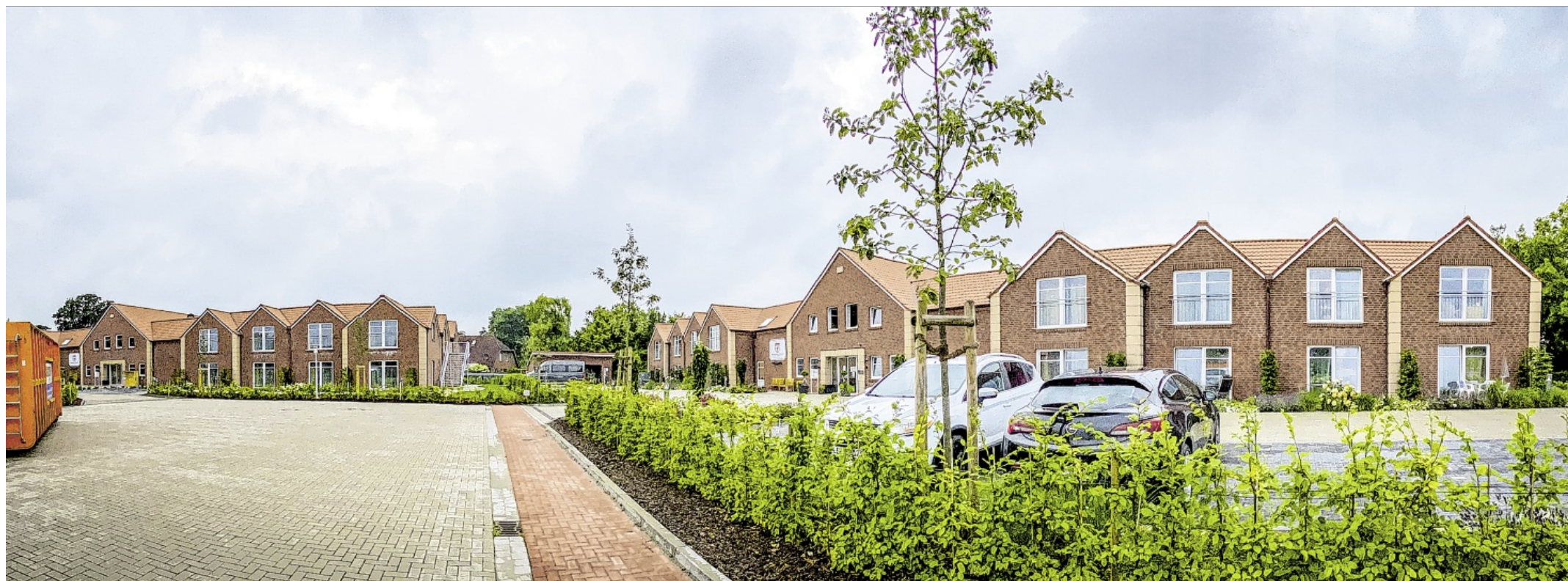
In Timmel ist ein zweiter Pflegetrakt (links im Bild) zum Wohnpark hinzugekommen. Kostenpunkt: mehr als elf Millionen Euro.
