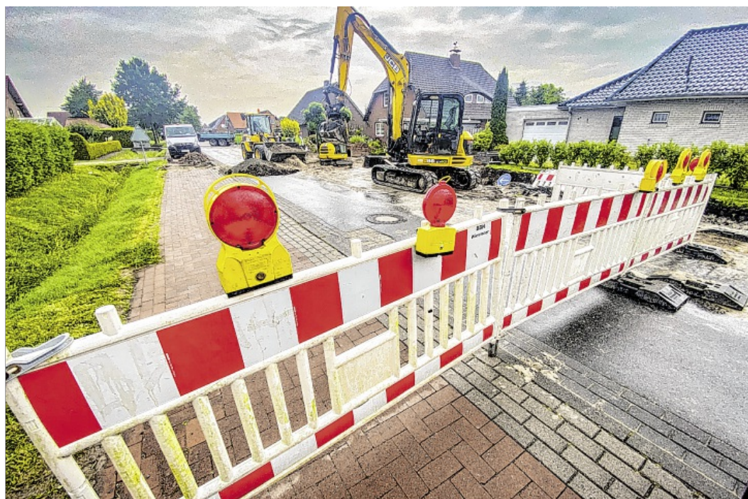
Vier Wochen lang kann wegen der Sanierungsarbeiten der Amselweg in Höhe der Baustelle nicht mehr passiert werden.
